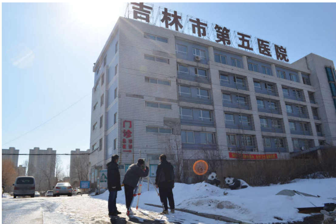
测绘人员现场施测
